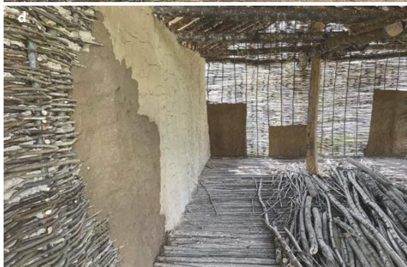
Wie man ein Pfahlbauhaus baut: ein Rost aus Eichenbalken (a), setzen der Pfosten für das Dach (b), flechten der Wände (c), verputzen der Flechtwände mit Lehm (d) How to build a lake dwelling: A grid of oak beams (a), setting the posts for the roof (b), weaving the walls (c), plastering the wattle walls with clay (d)
